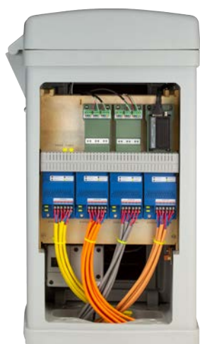
Abbildung 9: Mit Kabelbindern bleiben die Verdrahtung sauber und ordentlich.
